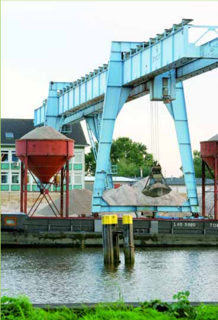
OLDENBURG: Güter wie Getreide, Futtermittel, Dünger und Baustoffe sind ebenso feste Umschlaggrößen wie Schwergutverladungen bis 750 t.
