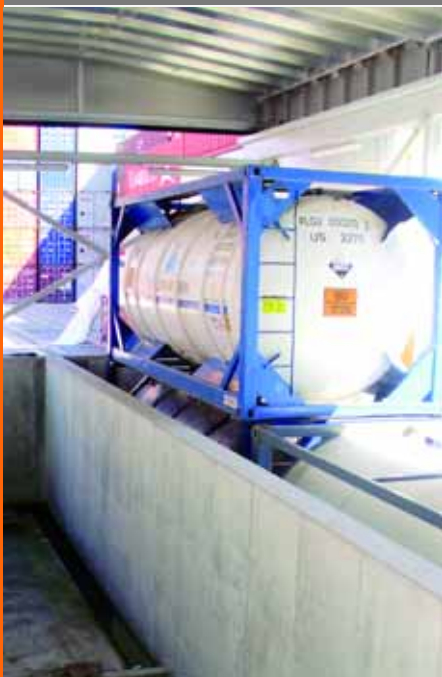
Unter (Schutz-)Dach und Fach: Die abgedichtete Gefahrgutwanne im Basel Multi Terminal fasst 18 Standard-Container.
